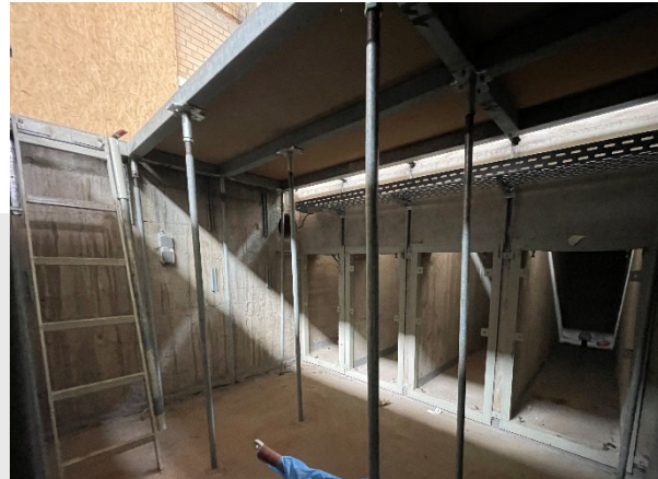
Teilunterkellerung ohne Decke Ziegelsteingeb.
