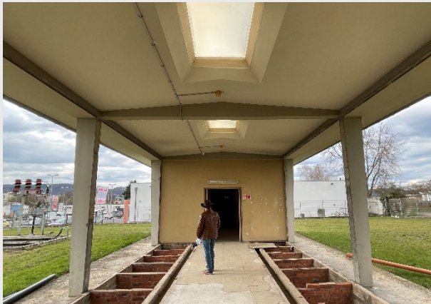
Überdachter Freiraum mit Bodenkanälen
