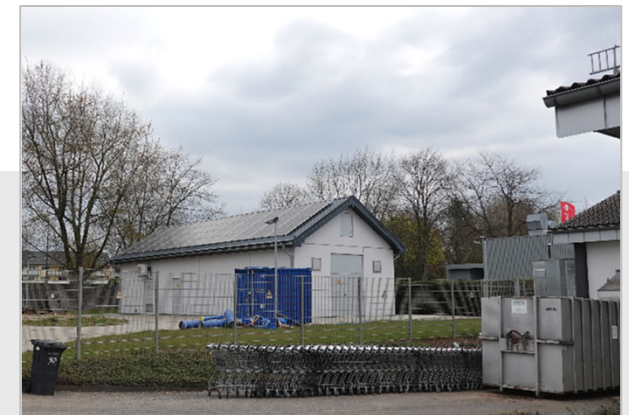
Neubau Umspannwerk SWT + Aldi
