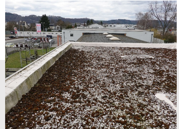
Dachaufsicht Flachdach + Betondach
